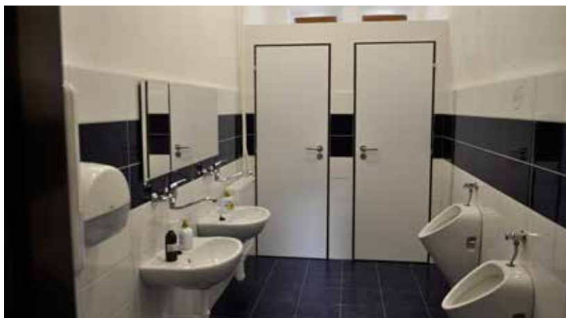
ZŠ a MŠ - WC po rekonstrukci
